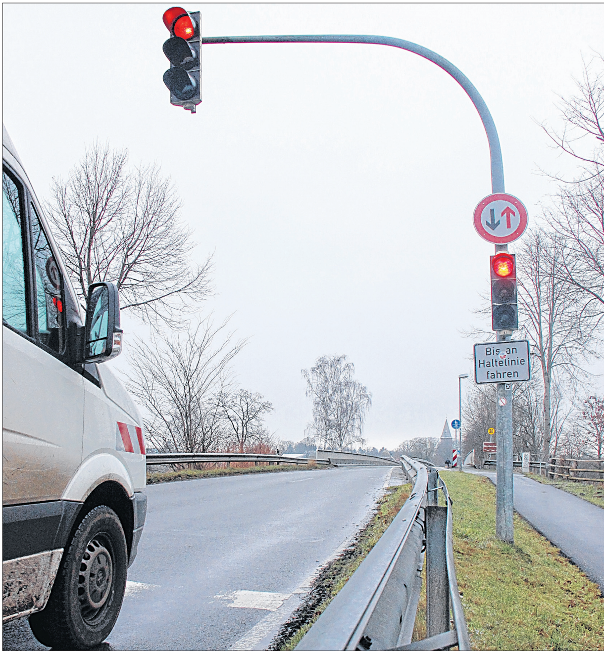
Wartende Autofahrer gibt es immer: Seit 25 Jahren ist die Kanalbrücke in Büchen halbseitig gesperrt. Eine Ampel regelt den Verkehr. Eine Gewichtsbeschränkung gibt es nicht. Fotos: Holger Marohn
